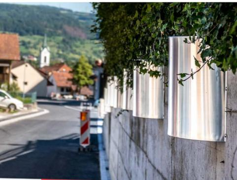
Eine Besonderheit sind diese neuen Schutzbleche über den hervorstehenden Maueranker. Sie sind flexibel und sollen speziell velofahrende Personen vor Verletzungen schützen, wenn diese aufgrund des Verkehrs dazu gezwungen werden, sehr nahe an der Mauer vorbeifahren zu müssen.
