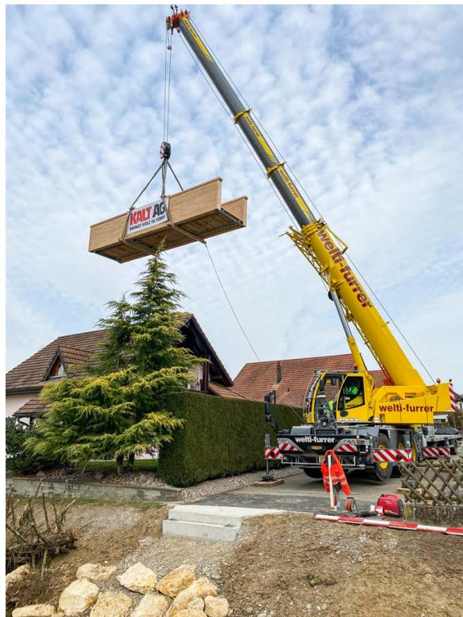
Am Freitag, 26. Februar wurde das 3,6 Tonnen schwere Bauwerk durch die ortsansässige Firma Kalt AG geliefert. Ein Pneukran hob die 6,40 Meter lange und 1,40 Meter breite Trogbrücke auf die vorbereiteten Widerlager am Ende der Vogelmattstrasse.
