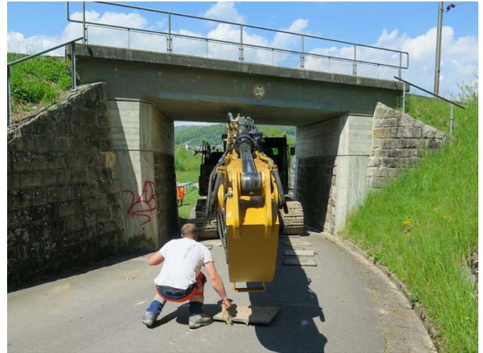
Nach der Durchfahrt wurde der Bagger wieder aufgeladen und zur Baustelle transportiert. Dasselbe Prozedere wiederholte sich beim Abtransport des Baggers.
