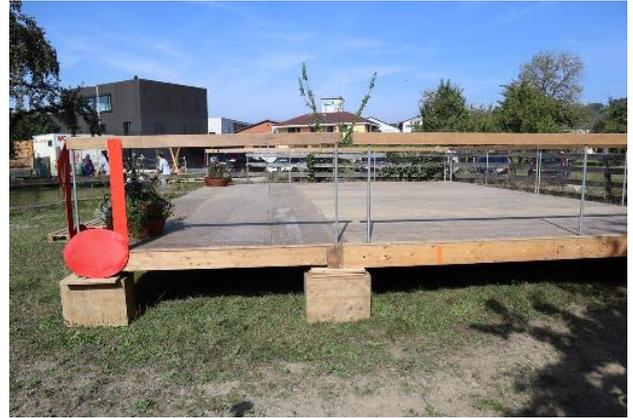
Geländerpfosten einstecken und Handläufe aufsetzen
