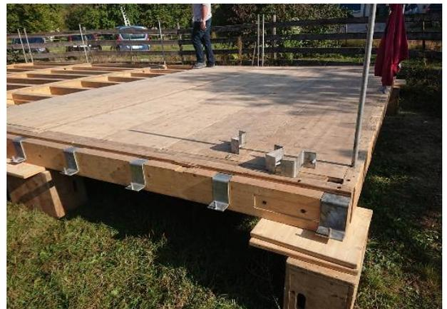
Zusammenbau erfolgt mittels Z-Eisen
